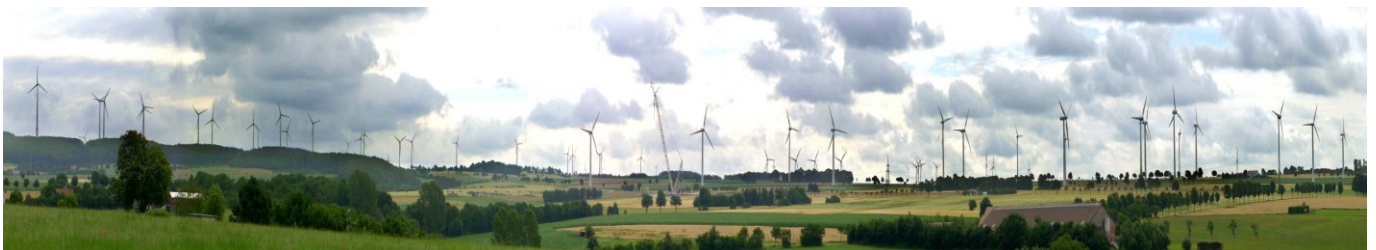
Ein so genannter „Windpark“ bei Neuenbeken, Kreis Paderborn mit 55 WEA (auf dem Bild!)
